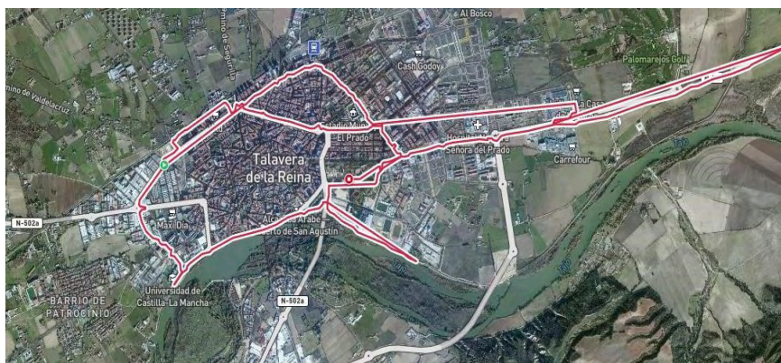
Ilustración 1. Fotografía General Carril Bici. Fuente propia.
