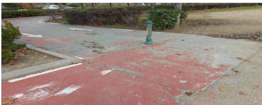
Ilustración 8. Obstáculos en la vía, Avenida de Madrid.
